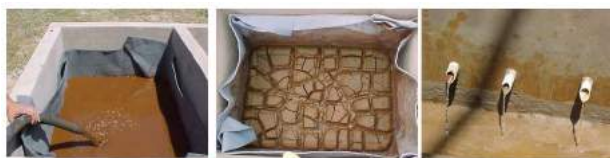
Figura 3. Leito de Drenagem em escala piloto na ETA de Rio Claro – SP. Fonte: Achon e Cordeiro (2003).
