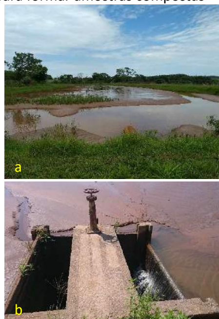
Figura 1. Lagoa de sedimentação de lodo, onde são encaminhados a Água de Lavagem dos Filtros (ALF) e Lodo do decantador (LD) (a) e o ponto de saída do sobrenadante da lagoa e o ponto de coleta das amostras (b).
