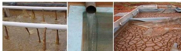
Figura 4. Leito de drenagem em escala real na ETA Cardoso – SP. Fonte: Fontana (2004).
