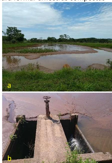
Figura 1. Lagoa de sedimentação de lodo, onde são encaminhados a Água de Lavagem dos Filtros (ALF) e Lodo do decantador (LD) (a) e o ponto de saída do sobrenadante da lagoa e o ponto de coleta das amostras (b).
