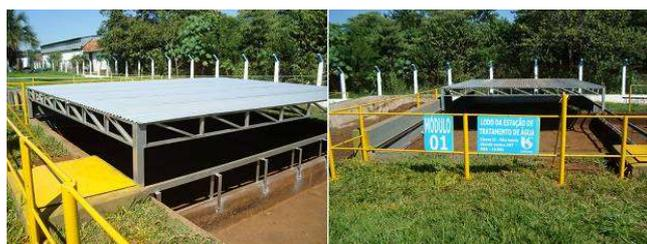
Figura 5. Cobertura móvel instalada no LD da ETA de Cardoso-SP. Fonte: Cordeiro *et al.* (2014).
